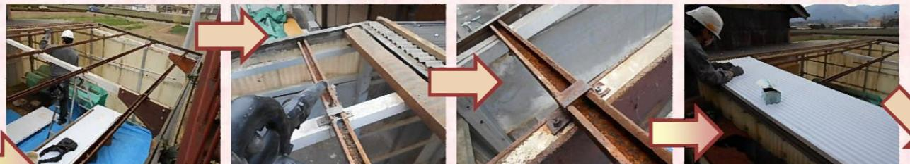
既存の波板を撤去し、骨組み部分の鉄骨に溜まっていたホコリやゴミを清掃してから
