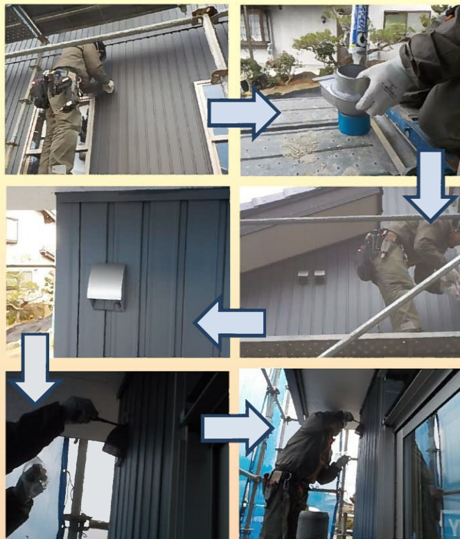
外壁工事が終わり屋外側の電気工事を行います。 換気フードや屋外コンセントを取り付けていきます。
