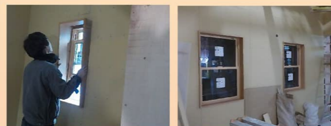
取り付けしたサッシの室内側に窓枠が取り付けられました。
