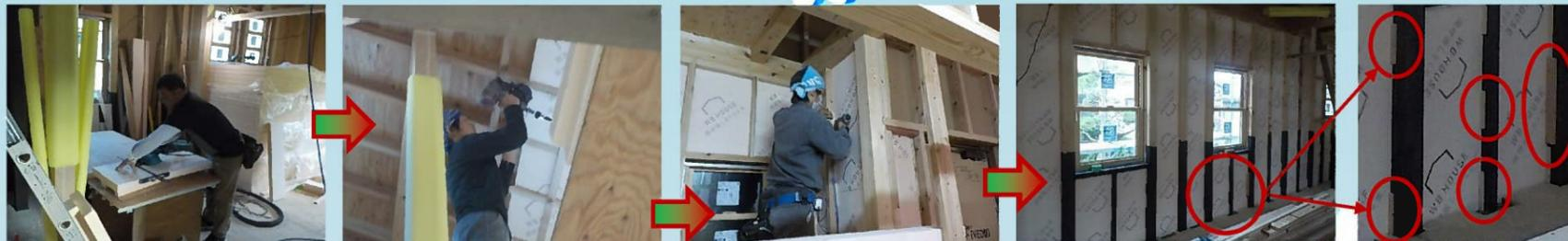
充填するサイズにカットした断熱材を1枚ずつ取り付け、断熱材が浮いてこないように棧で止めています。
