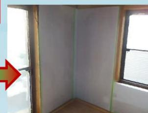
土壁部分には養生板で保護し、開口部分はブルーシートで覆います。
