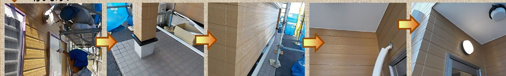
水切り部分を塗って塗装工事完了です(^_^)v キレイに仕上がりました。
