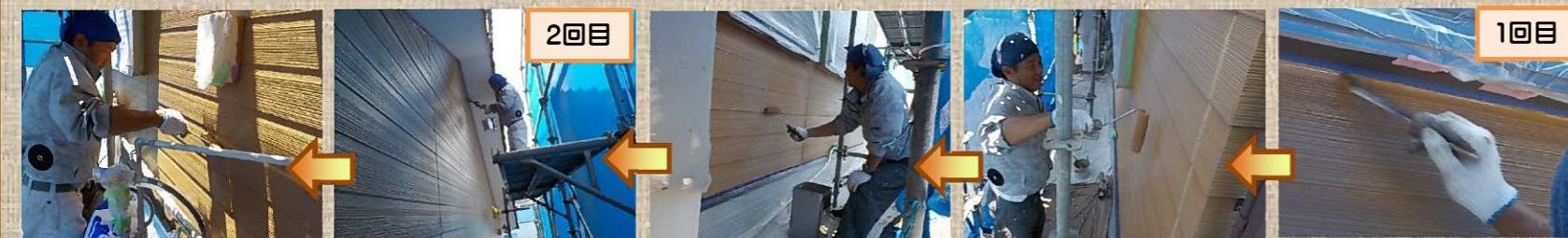
1回目の塗料が乾いたら仕上げ塗り2回目を行います。
