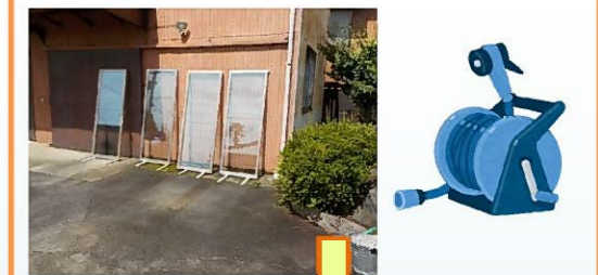
サッシを取り外し、工事中のホコリや汚れを洗い流して拭き上げます。
