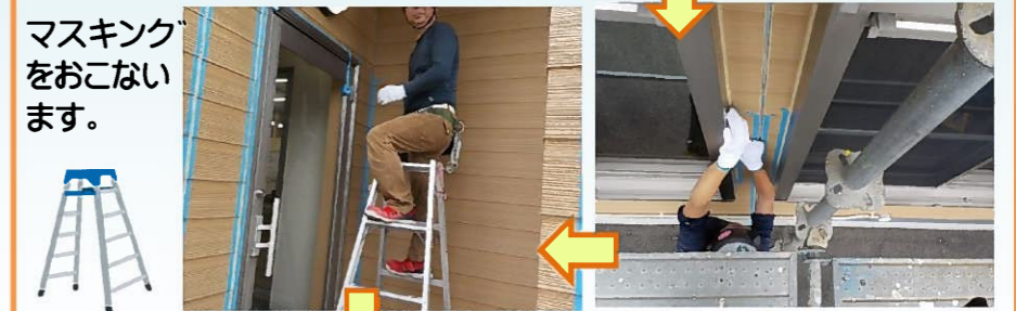
新たにコーキングを充填していきます。
