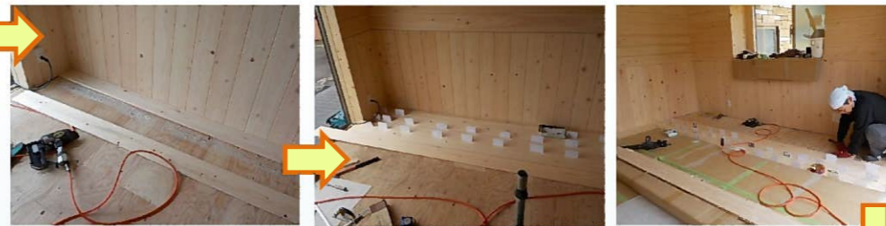
床板を貼っていきます。床板も壁板と同じ桧の無垢板を貼っていきます。
