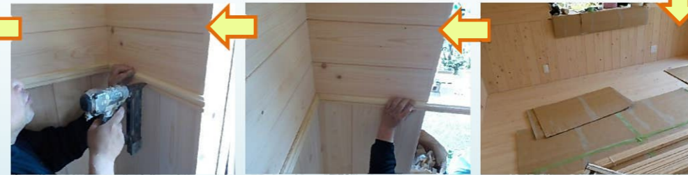
中間見切りを取り付けていきます。
