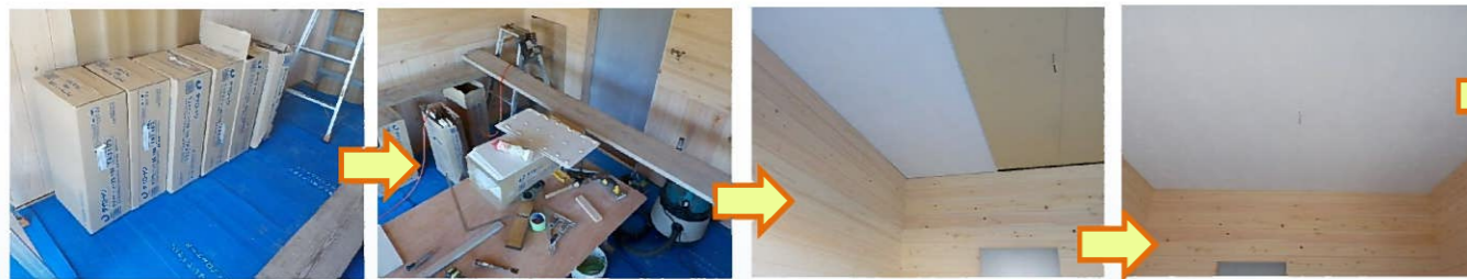
天井材が運び込まれ、一枚ずつ貼っていきます。今回使用する天井材は吸音・調湿・消臭効果があります。
