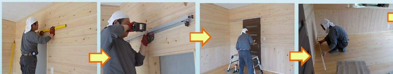
ワックスが乾いたら内装建具を取り付けます。今回はアウトセットの片引き戸を取り付けました。
