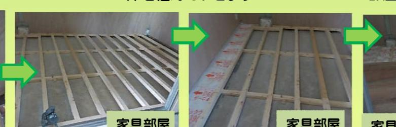
家具部屋も同じように天井、壁、床に断熱を充填して合板を貼っていきます。
