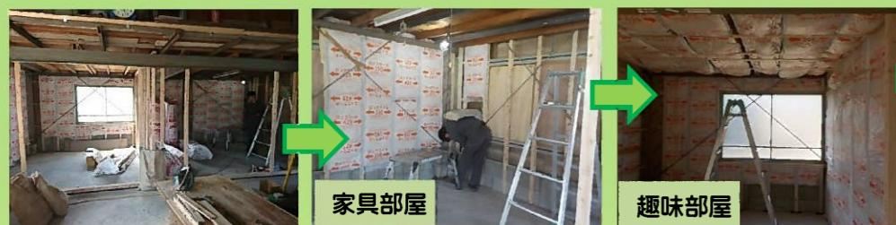
間仕切りの柱が組まれ、断熱材を充填していきます。
