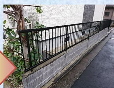
支柱への被害がなかったため、縦格子フェンスのみ取り替えました。年末ギリギリでの取り替え工事となってしまいましたが、キレイになった状態で新年を迎えていただく事ができて良かったです(^^)
