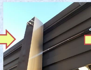
アルミの支柱にホルトでしっかり固定されました。これで安心です(^^)
