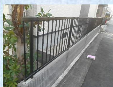
何カ所かの縦格子が曲がったり、キズが入っている状態でした(>_<)被害のあったフェンスを全て取り替えます。
