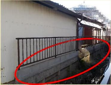
写真奥の擁壁が崩れかけています(>\_<)
