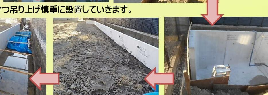
プレキャスをクレーンで一つずつ吊り上げ慎重に設置していきます。
