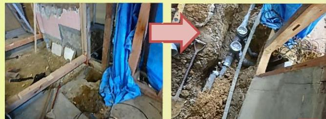
浴室とトイレの給排水工事を施工していきます。
