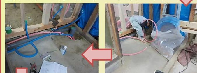
室内側の給排水管へ接続していきます。
