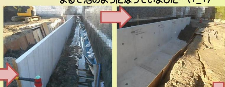
プレキャスを設置する為に打設した部分に水路の水が入り込んでため池のような状態になってしまい、ポンプを設置して急いで水を排出します。
