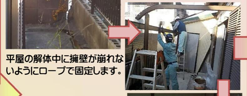
平屋の解体中に擁壁が崩れないようにロープで固定します。
