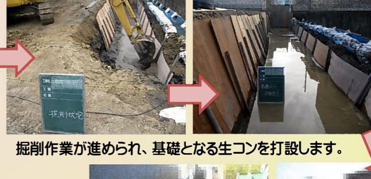
掘削作業が進められ、基礎となる生コンを打設します。
