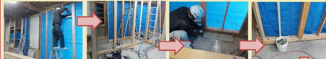
土台部分や柱を組み上げ、補強金物を取り付けていきます。
