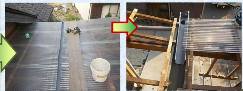
ポリカ波板の片側を一旦外して、湾曲してしまった箱樋を撤去します。
