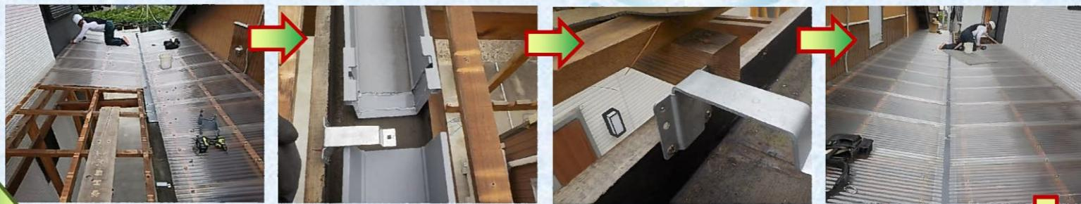
新しい箱樋を設置し補強金具を取り付け、ポリカ波板を戻していきます。
