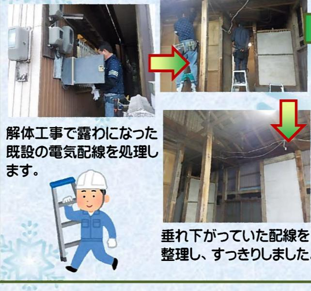
解体工事で露わになった既設の電気配線を処理します。
