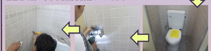
壁のネジ穴を塞ぎます。洋風便器とタンク、紙巻器を取り付けます。
