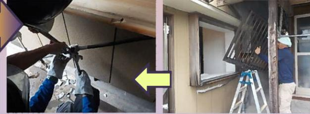
配管を撤去します。 出窓部分のサッシや格子を取り外します。
