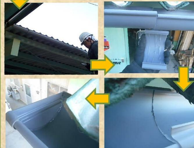
軒樋の継ぎ目部分は継手部材を取り付け、
