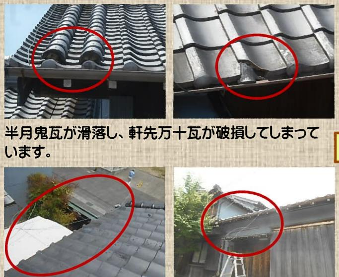
半月鬼瓦が滑落し、軒先万十瓦が破損してしまっています。
