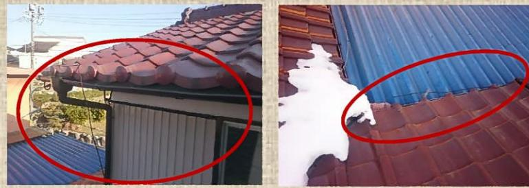
写真ではちょっと分かりづらいですが…(>\_<) 軒先瓦煽り止め鉄線が滑落して垂れ下がっている状態でした。
