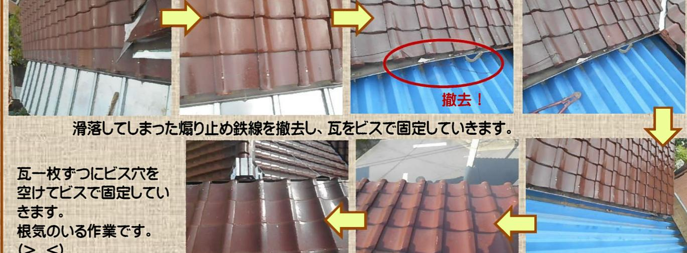
滑落してしまった煽り止め鉄線を撤去し、瓦をビスで固定していきます。
