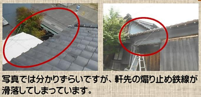
写真では分かりづらいですが、軒先の煽り止め鉄線が滑落してしまっています。
