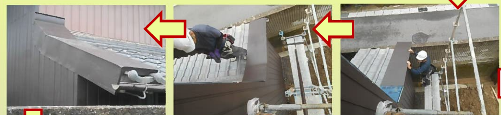
切り離した北側の屋根部分にGL鋼板を張っていきます。
