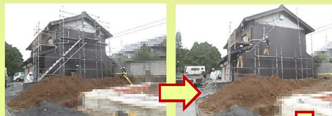
足場を手早く解体していきます。
