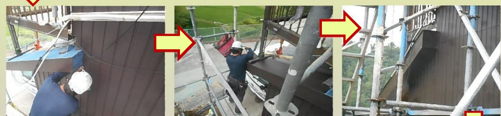
次に南側の屋根部分にGL鋼板を張っていきます。
