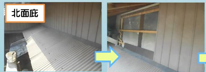
破損した波トタンを撤去するために外壁も一旦撤去します。
