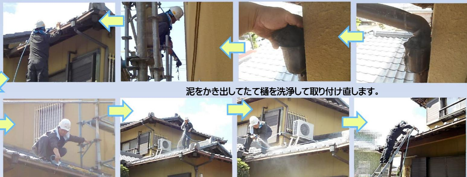
泥をかき出してたて樋を洗浄して取り付け直します。
