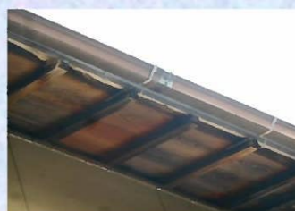
軒樋が湾曲し、樋の接 続部から雨漏りが していました。
