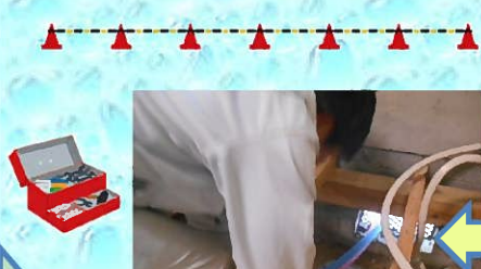
壁からの給水給湯管を床下からに経路変更します。
