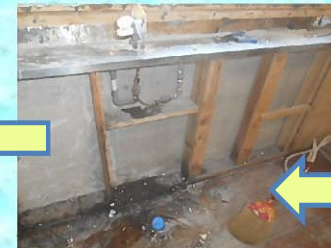
流し台裏の壁板を解体してびっくり！水道管が水漏れをおこしていました(>_<)
