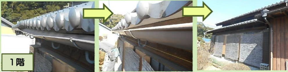
【 離れ 南面1階 & 2階軒樋受け金物取り替え 】
