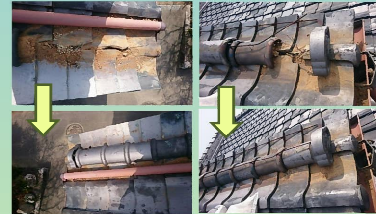
【 母家南面東側修繕 】
