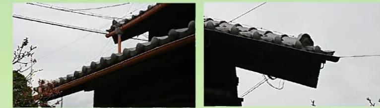
【 離れ南面 & 北面修繕完工 】
