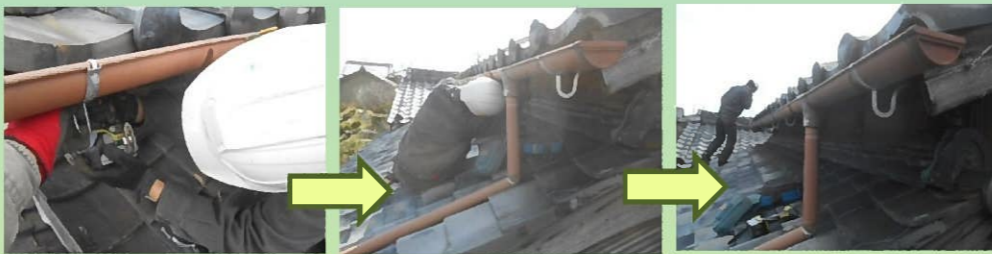
【 小屋 大屋根軒樋 & 受け金物取り替え 】
