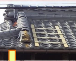
【北面2階】 ずれてしまっていた下りのし瓦を戻します。
