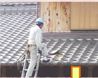
【北面1階】 割れた瓦を新しい瓦に差し替えます。
