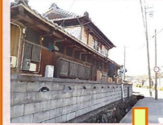
【北面1階】 湾曲した樋や受け金物、割れてしまっていた集水器を取り外し、新たに取付けます。
