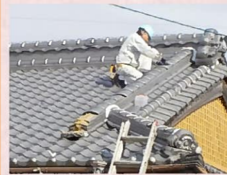
外れてしまった鬼瓦を取り付けます。
