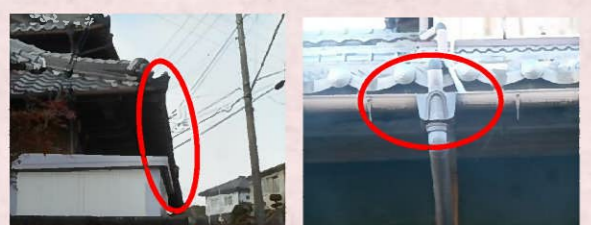
【北面1階】 樋が湾曲し、集水器が割れてしまっています。
