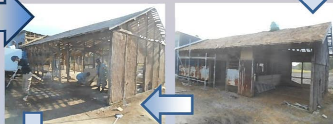
屋根瓦を撤去し、壁土を取り除きます。
