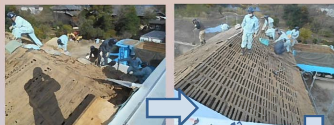
屋根瓦を撤去し、壁土を取り除きます。
