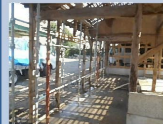
足場で梁をしっかりと支えます。
