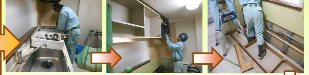
既存キッチンの撤去を行います。対面カウンターや垂れ壁と腰壁の一部は残すので、慎重に撤去作業を進めます。
