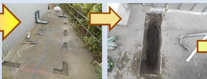
基礎工事にかかります。アンカーボルトを埋め込む為、アスファルトを剥がし掘削します。
