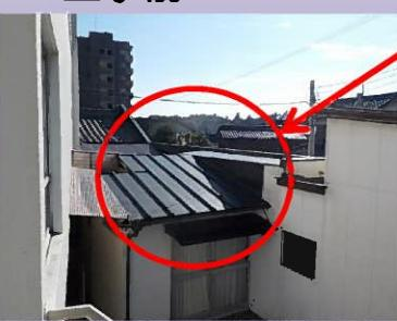
鋼板の屋根部分と笠木部分を塗装し直します。
