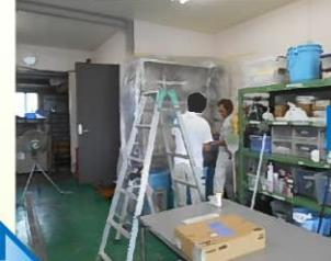
粉が飛び散らないように掃除機で吸いながら床に切込みを入れ、はつていきます。
