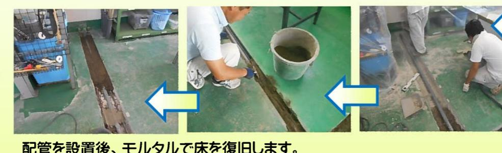
配管を設置後、モルタルで床を復旧します。
