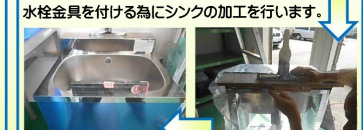
水平器で傾きをチェックしながらシンクを設置します。
