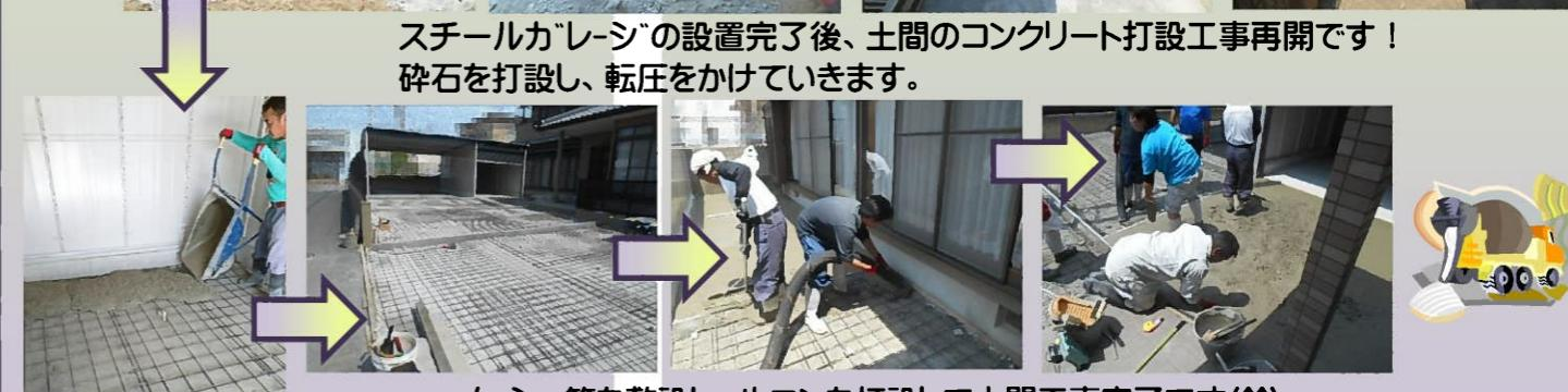
スチールガレージの設置完了後、土間のコンクリート打設工事再開です！
