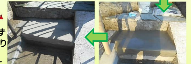
面の仕上げをして完成です！
