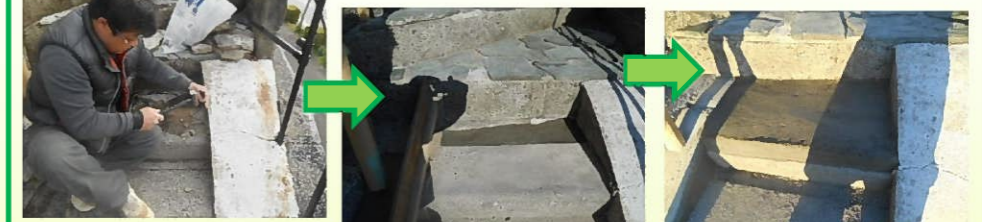
割れてしまっていた部分を撤去します。
