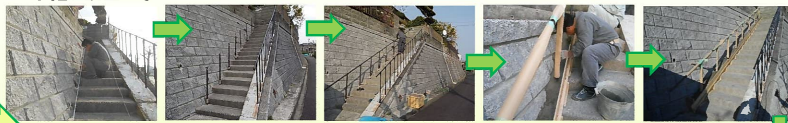
支柱を取り付ける位置に印を付け、設置していきます。
