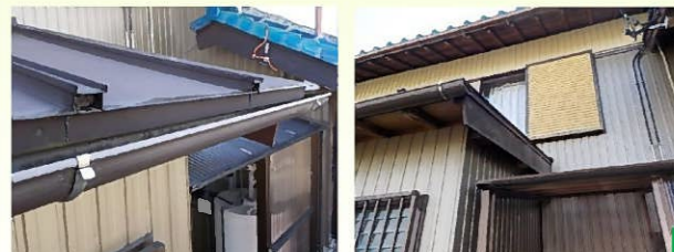
母家北側の鋼板屋根の部分だけ塗り直します。
