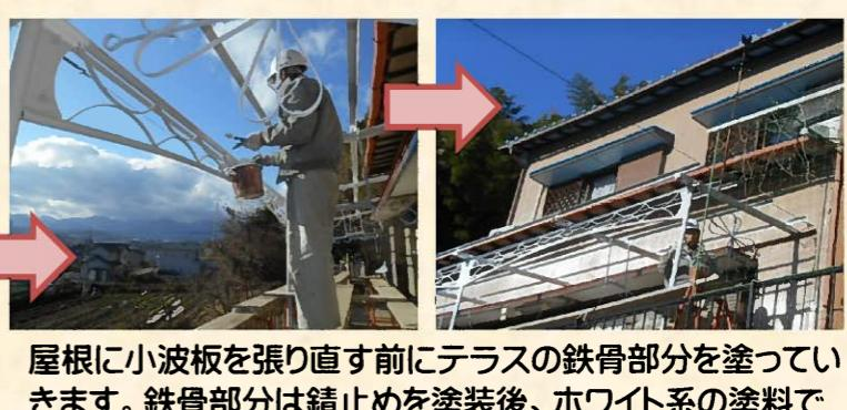
屋根に小波板を張り直す前にテラスの鉄骨部分を塗ります。鉄骨部分は錆止めを塗装後、ホワイト系の塗料で仕上げます。
