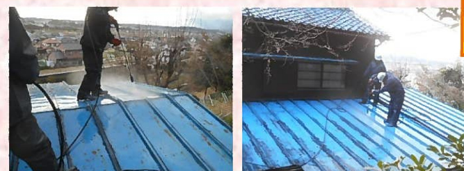
塗装工事の前に高圧洗浄機で一気に汚れを洗い流します(^o^)/
