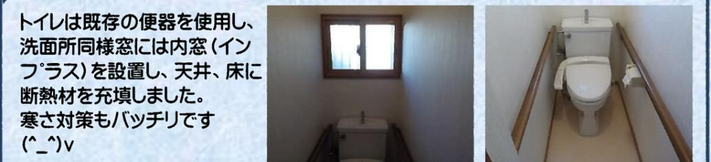
トイレは既存の便器を使用し、洗面所同様窓には内窓(インプラス)を設置し、天井、床に断熱材を充填しました。
