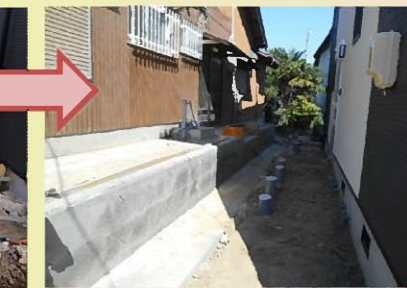
土止め工事完了です！ スロープ工事にかかります
