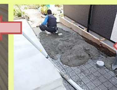
生コンを打設していきます。
