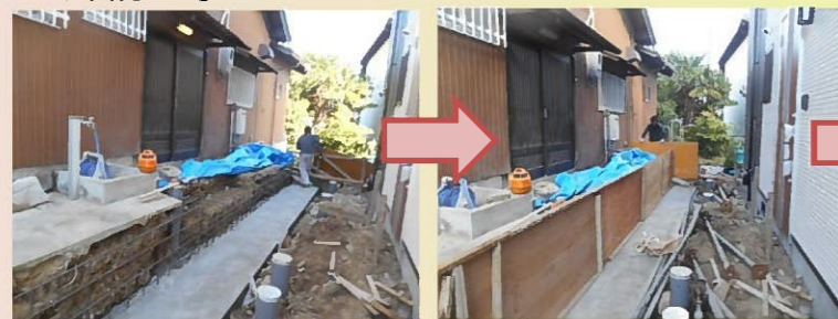
打設した生コンが乾いたので、側面の工事にかかります。
