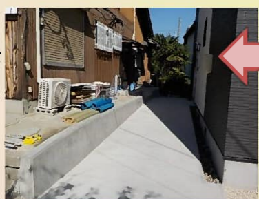
スロープの完成です！
