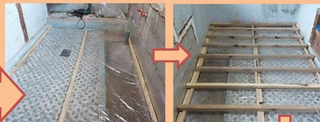
断熱材充填後、構造用合板を張って床の嵩上げ工事完了です。
