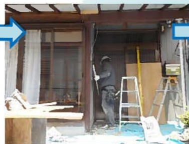
既存壁の一部を撤去し、下地材を張っていきます。
