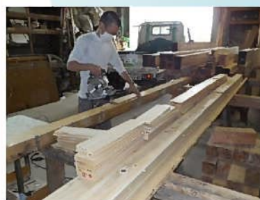
小幅板を一枚ずつ加工しています。 壁に使用する無垢材には、自然塗料いろはを塗布します。
