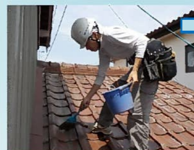
漆喰を塗り直す前に清掃作業です！
