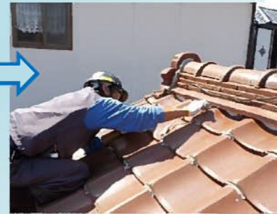
漆喰を新たに塗り直していきます。根気のいる作業です。
