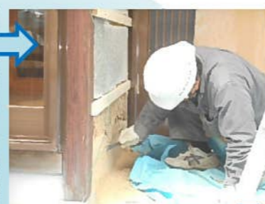
既存壁の一部を撤去し、下地材を張っていきます。
