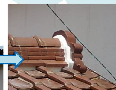
工事完了です！ 綺麗に漆喰が塗り直されました(^ ^)
