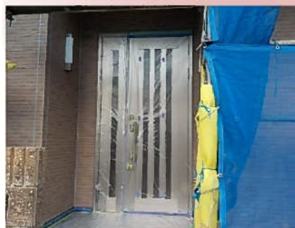
養生完了！塗装工事にかかります。
