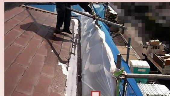
屋根から順番に高圧洗浄で一気に汚れを洗い流していきます。
