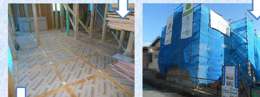
外廻りではダイライトMSが張られ、壁の部分が出来上がっていきます。 家らしくなってきたでしょ～(^o^)
