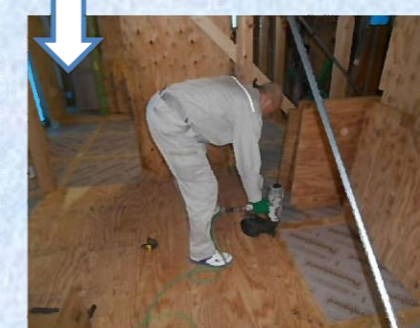
基礎断熱 → 床断熱 → 床板の順に工事を進めます。
