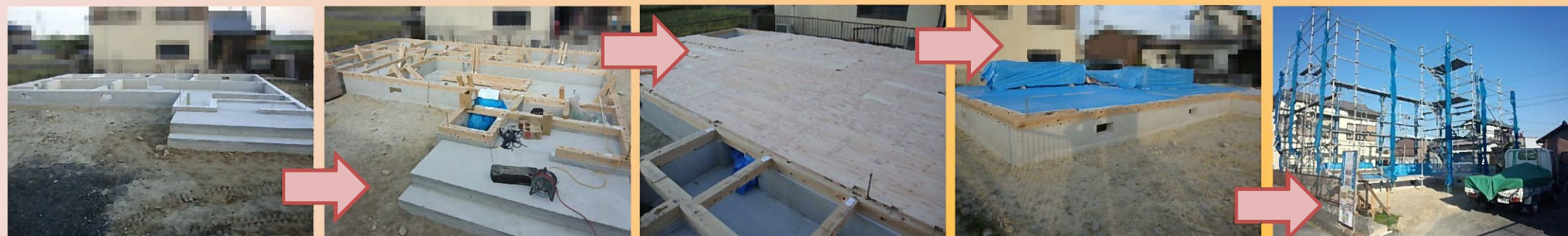
養生期間が終わり、床が組まれていきます。
