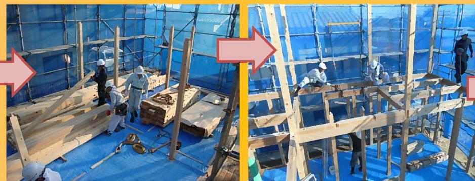
次々と柱が立てられ、梁が組まれていきます。
