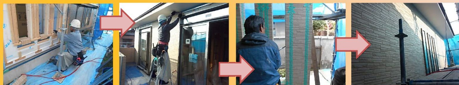
外壁材を張っていきます。
