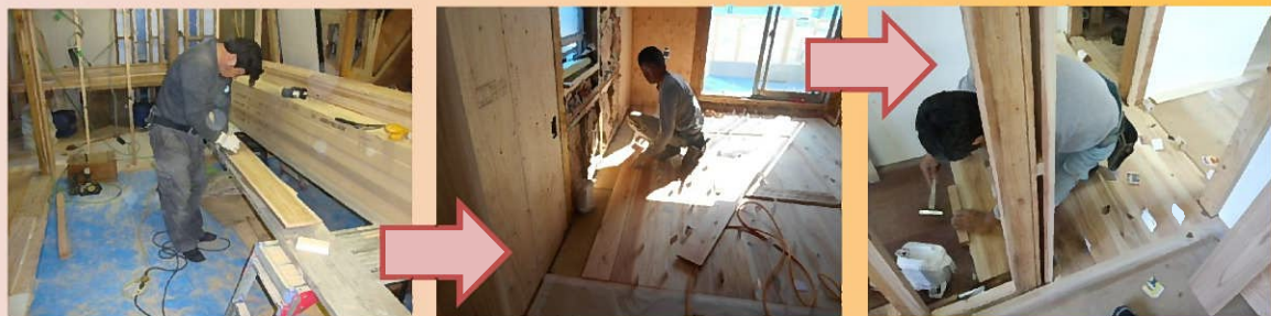
杉の無垢板を加工し、一枚ずつ丁寧に張って床を仕上げしていきます。
