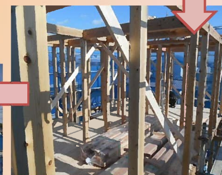
構造用合板が張られ、床部分が出来上がると次々と柱が立てられ、梁と組まれていきます。
