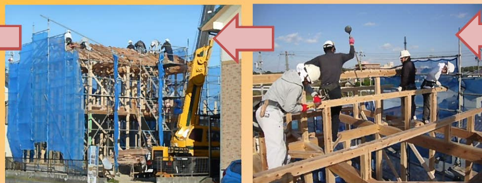
構造用合板が張られ、床部分が出来上がると次々と柱が立てられ、梁と組まれていきます。
