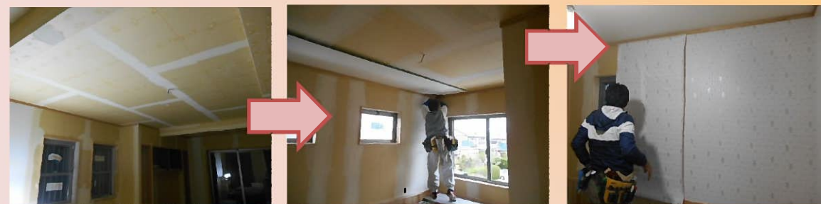
天井 & 壁のパテ処理後、クロスを貼って仕上げっていきます。
