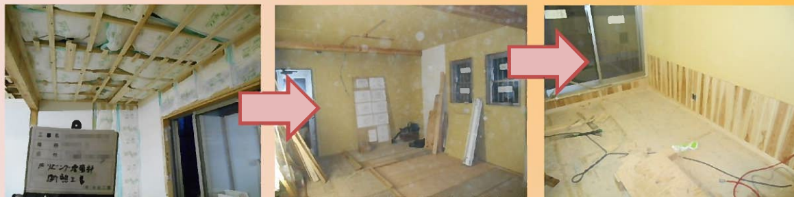
天井と壁にも断熱材を充填し、プラスターボードを張り、腰壁には杉の無垢板で仕上げます。
