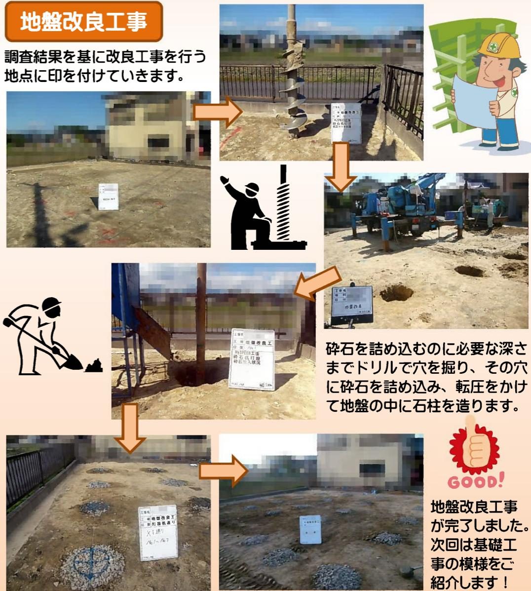
碎石を詰め込むのに必要な深さまでドリルで穴を掘り、その穴に碎石を詰め込み、転圧をかけて地盤の中に石柱を造ります。
