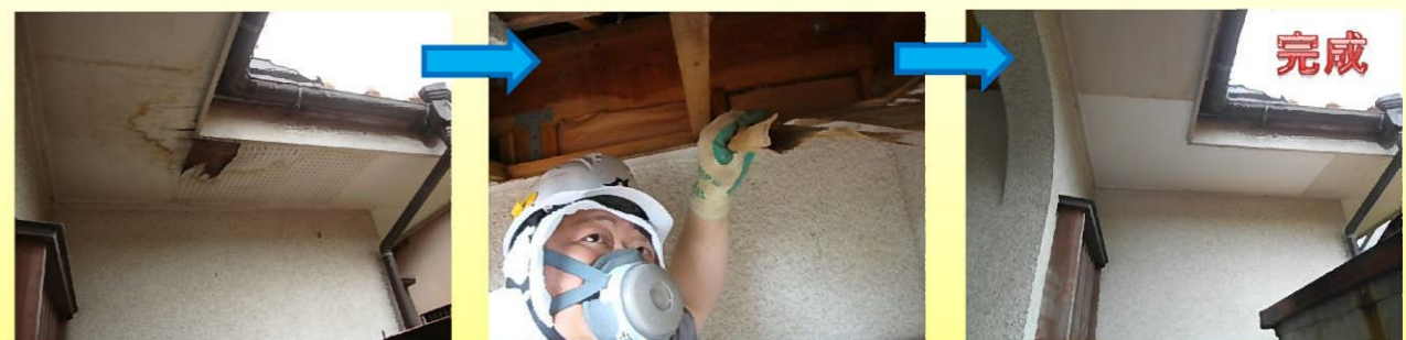
傷みが激しい軒天を撤去し、新たに軒天を張り直しました。
