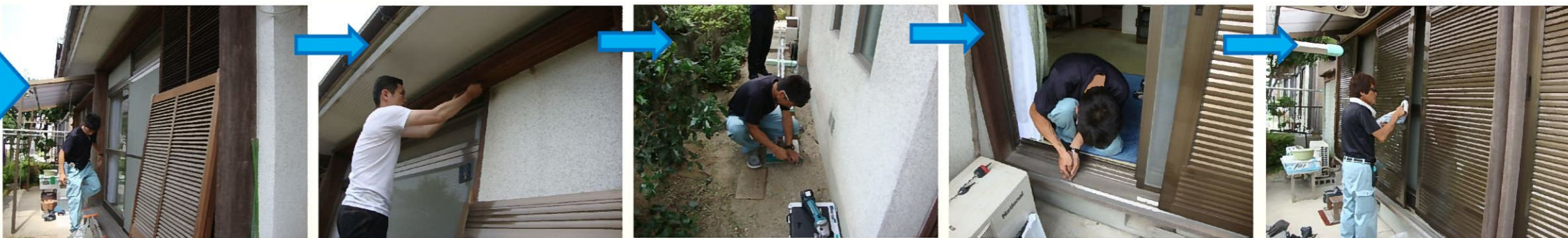
雨戸が搬入され、取り替え工事開始です！
