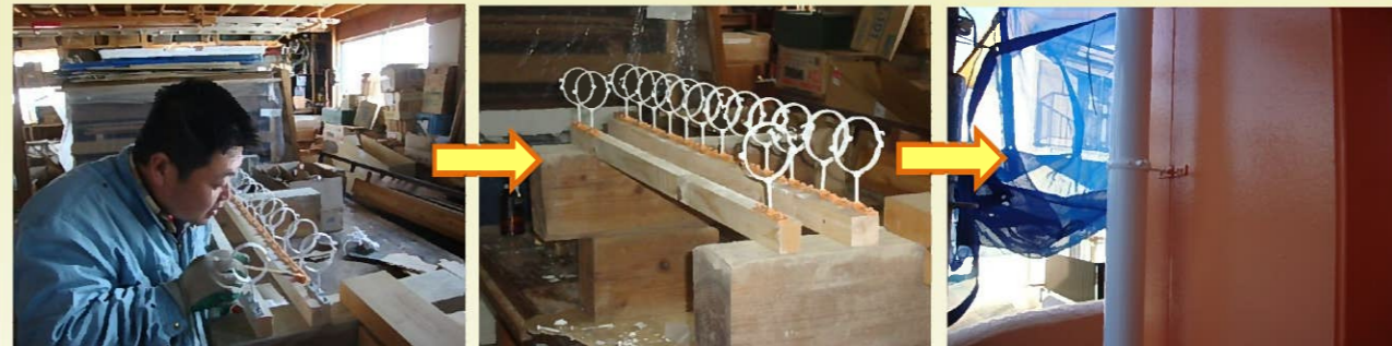
堅樋を固定する金物の塗装をしています。堅樋を復旧した時に外壁と違和感が出ないように小技を効かせます(^)
