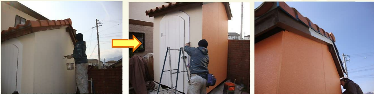
ヌックの塗装に取り掛かります。外壁と同じ色で仕上げます
