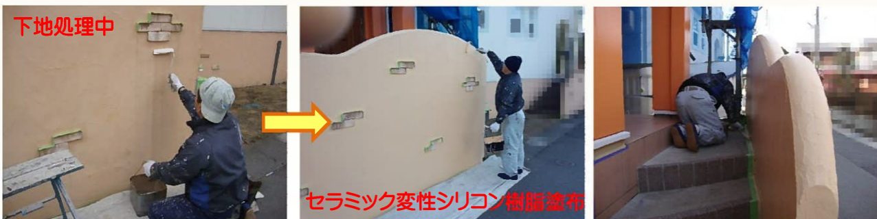
擁壁の塗り替えも行いました。外壁同様、下地処理をしてからセラミック変性シリコン樹脂を塗布していきます。
