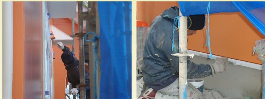
土台水切りや鋼板底などの細かな部分も丁寧に塗装します。
