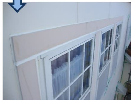
コーキング充填完了です！ 綺麗に仕上がっていますよ～(^_^)
