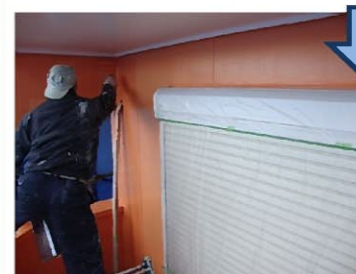
セラミック変性シリコン樹脂2回目塗布 大小さまざまなサイズの刷毛やローラーを使って7細かな部分も塗装していきます。
