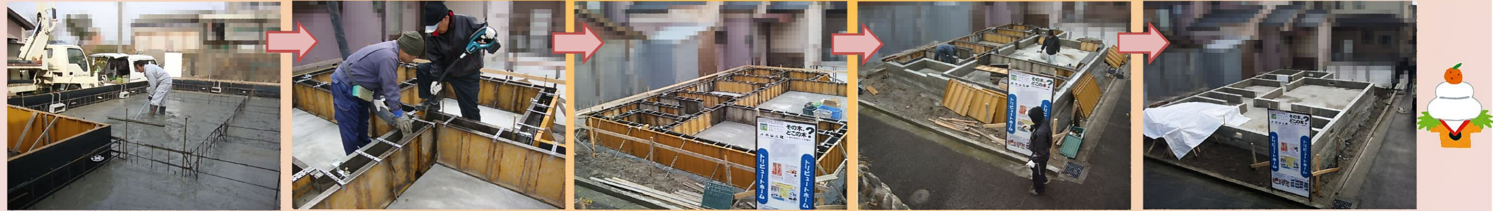
基礎立ち上がり部分の型枠を組み、生コンの打設作業を行います。
