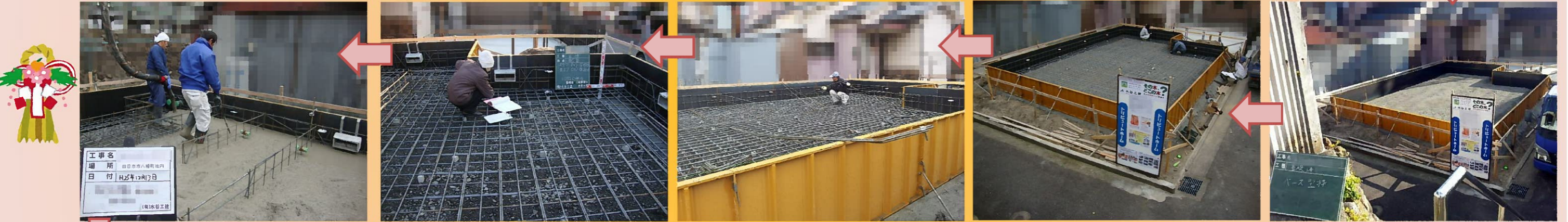
配筋検査合格後、生コンの打設作業を行います。
