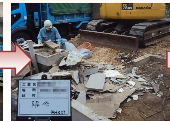
最後に基礎部分や外構のブロックなどの解体を行い、解体工事完了です。
