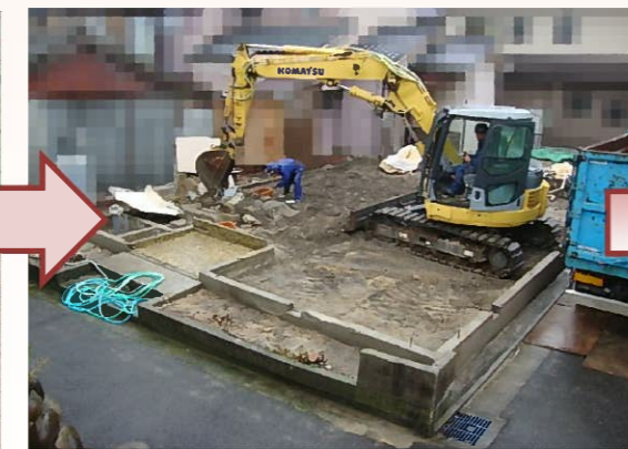
最後に基礎部分や外構のブロックなどの解体を行い、解体工事完了です。
