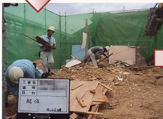
細かい部材などは分別しながら手作業で運び出します。
