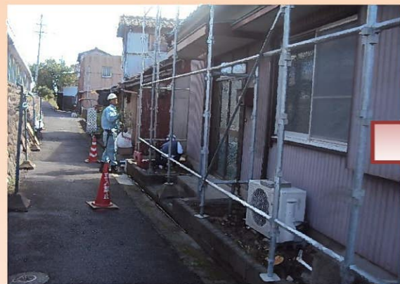
施主様ご家族のお引越しが完了し、いよいよ解体工事です。まずは足場の設置工事です。
