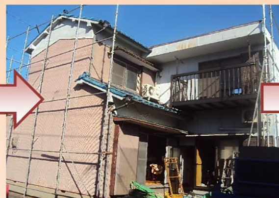
施主様ご家族のお引越しが完了し、いよいよ解体工事です。まずは足場の設置工事です。
