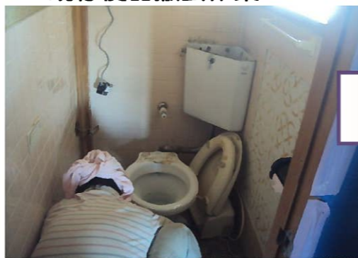
≪ 既存便器撤去作業 ≫
