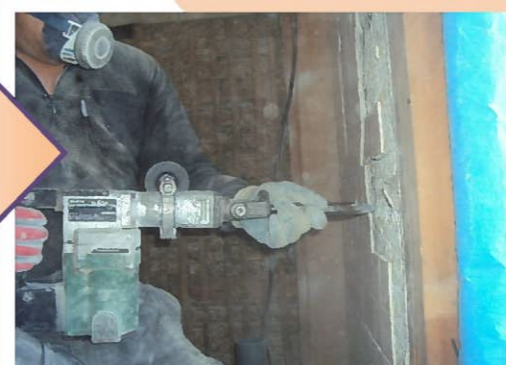
≪ 既存壁撤去作業 ≫ 既存壁を撤去し、トイレ部分が広がりました。
