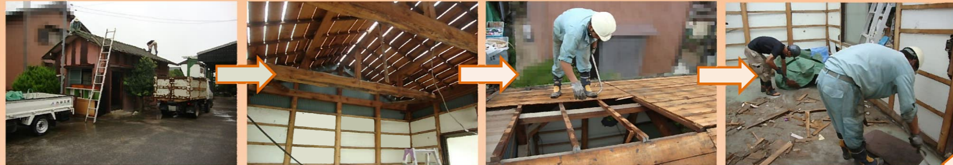
解体工事が始まりました！ まず、屋根瓦の撤去から始めます。
