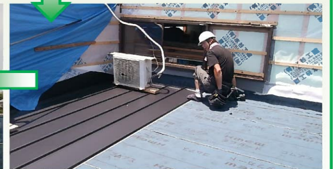
今回の屋根材には「ガルバリウム鋼板」を使用します
