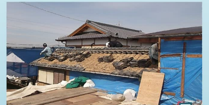
切妻だった屋根を解体し、片流れの屋根に変えちゃいます！
