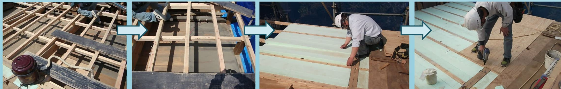
木くずやほこりなどを清掃後、断熱材を充填し合板を張っていきます。
