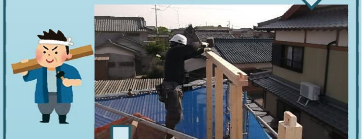
切妻だった屋根を解体し、片流れの屋根に変えちゃいます！
