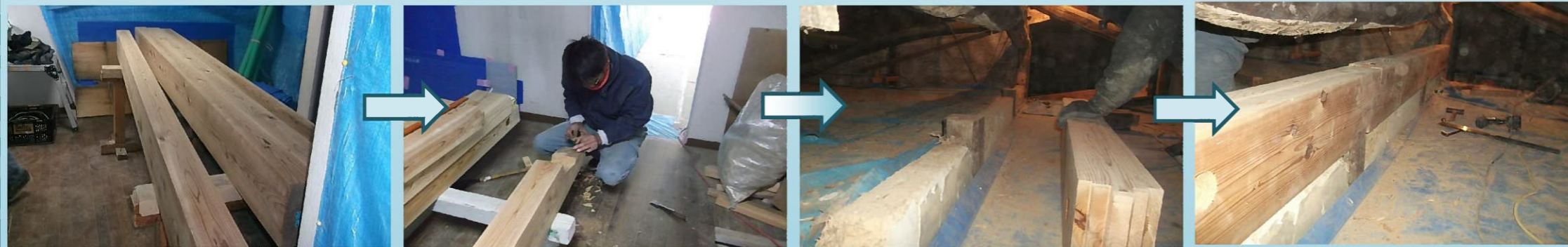
母屋となる材木を1本ずつ加工していきます。
