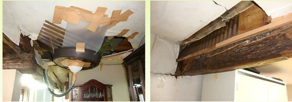
平屋屋根と増築した2階部の間で谷樋になっており、雨の際に箱樋をオーバーフローしてしまうため雨漏りが起きたと考えられます。
