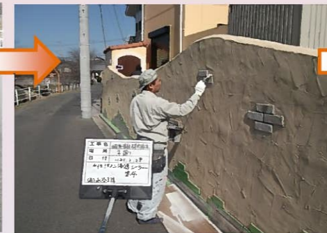
擁壁部分も塗装を行います。外壁と同じ色で仕上げます。
