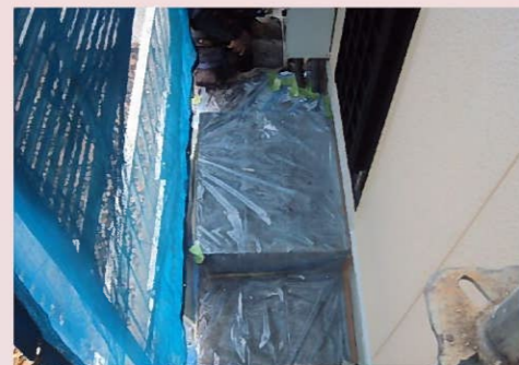
養生をしっかりしてから塗装作業にかかります。
