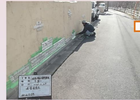
擁壁部分も塗装を行います。外壁と同じ色で仕上げます。
