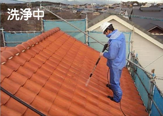
瓦に付いた黒ずんだ汚れを高圧洗浄を使って洗い流していきます。
