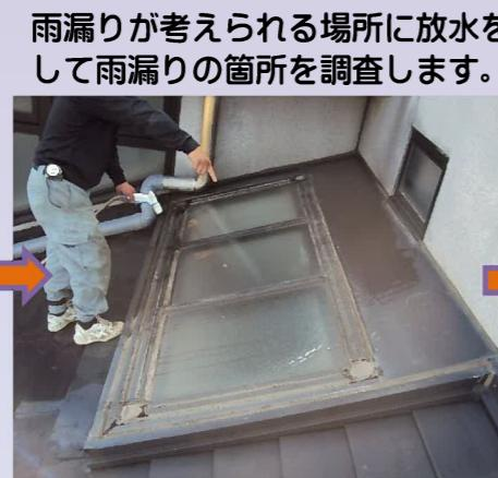
雨漏りが考えられる箇所に放水をして雨漏りの箇所を調査します。
