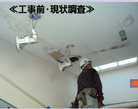
長年の雨漏りで天井にシミができてしまっている状態でした(>\_<)
