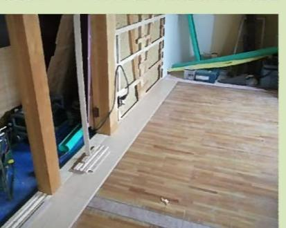
既存のフローリングの上に新しいフローリング材を貼っていきます。
