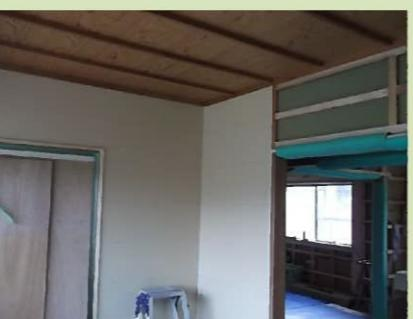
和室の塗り壁をクロス壁にする為に、新たに壁下地を作り、プラスチックボードを貼っていきます。
