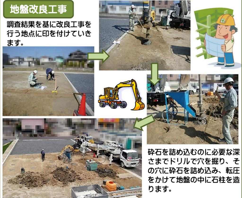
砕石を詰め込むのに必要な深さまでドリルで穴を掘り、その穴に砕石を詰め込み、転圧をかけて地盤の中に石柱を造ります。
