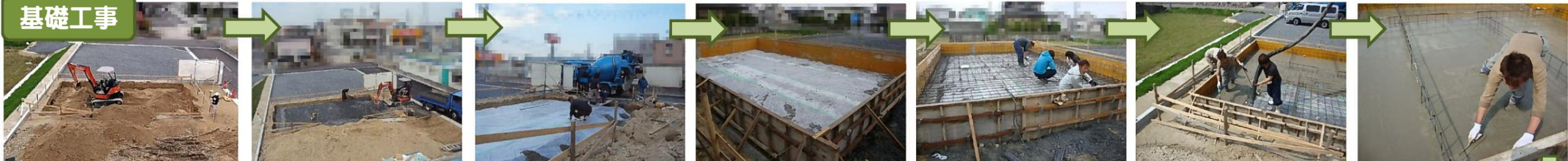
丁張作業→掘削作業→砕石打設作業後、防湿シートを敷き詰め、型枠を組みます。
